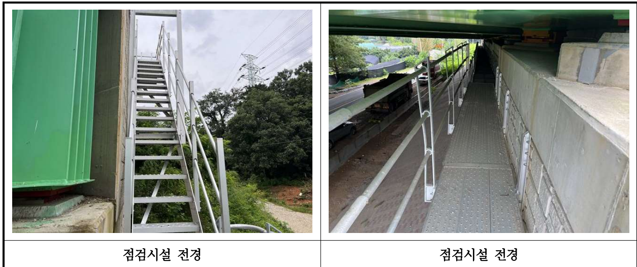
【사진 26.3.23】 교량 점검시설 전경
