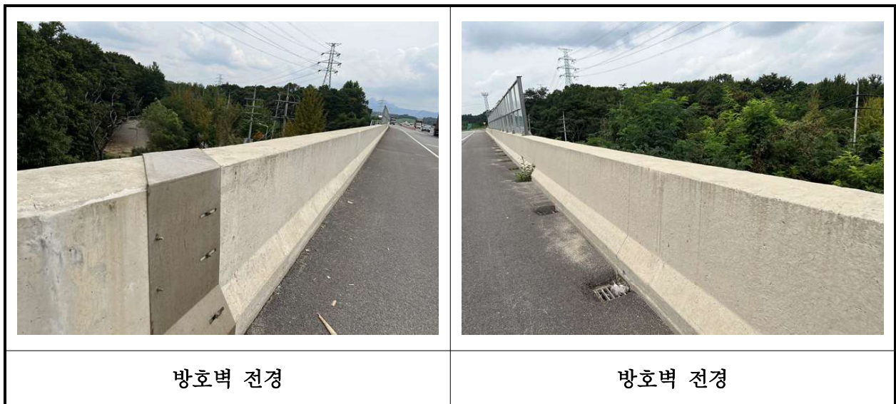
【사진 26.3.21】 방호벽 전경
