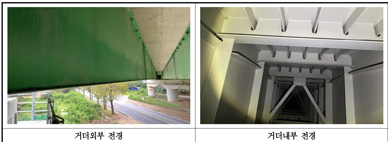
【사진 26.3.4】 거더 전경
