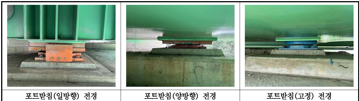
【사진 26.3.10】 교량받침 전경
