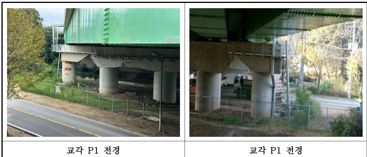
【사진 26.3.8】 교각 전경
