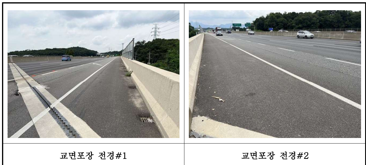
【사진 26.3.17】 교면포장 전경
