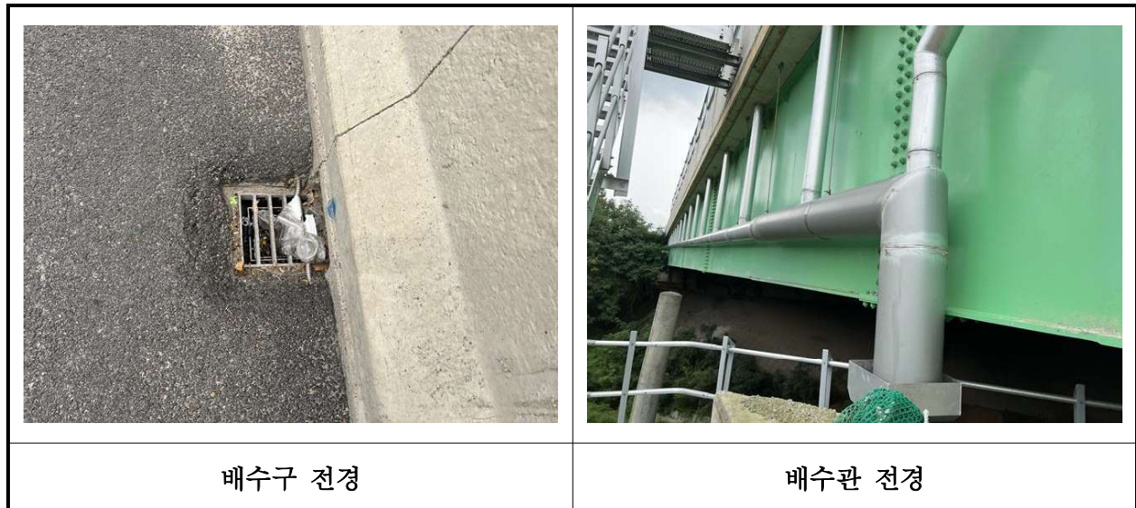
【사진 26.3.19】 배수시설 전경
