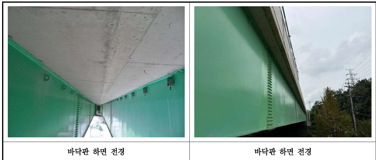
【사진 26.3.2】 바닥판하면 전경
