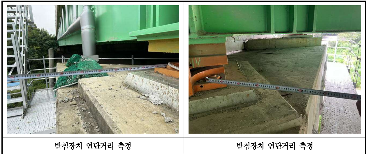
【사진 26.3.12】 교량반침장치 연단거리측정
